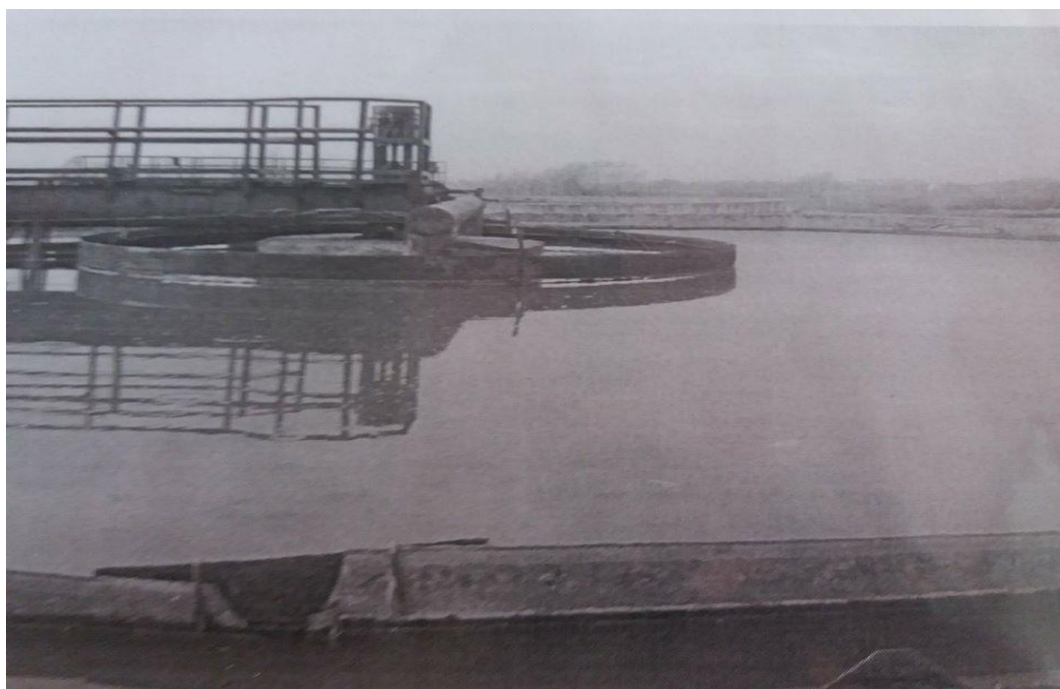
Рис.1.5. Пісковловлювач з круговим рухом води* Джерело: розроблено автором.
