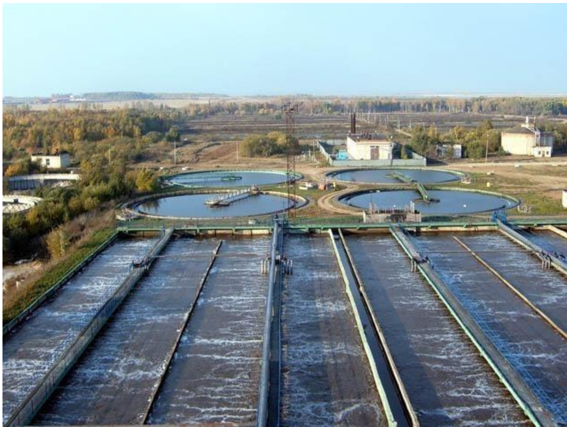
Рис. 1.2. Вигляд очисних споруд *
