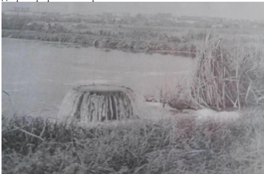
Рис.1.7. Біоставки на очисних спорудах «Ковельводоканалу»* Джерело: розроблено автором.
