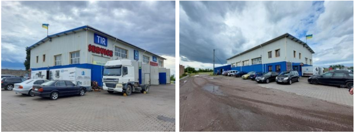
Рис. 2.7. Фотофіксація виробничо-складської будівлі.
