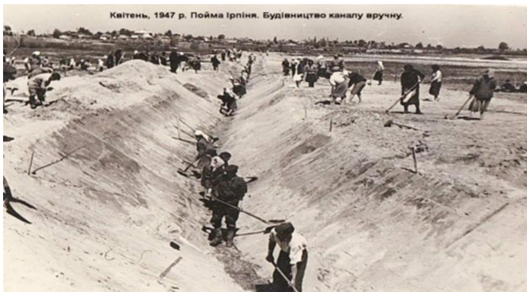
Рис. 3.6. Квітень, 1947 рік. Будівництво каналу вручну.
